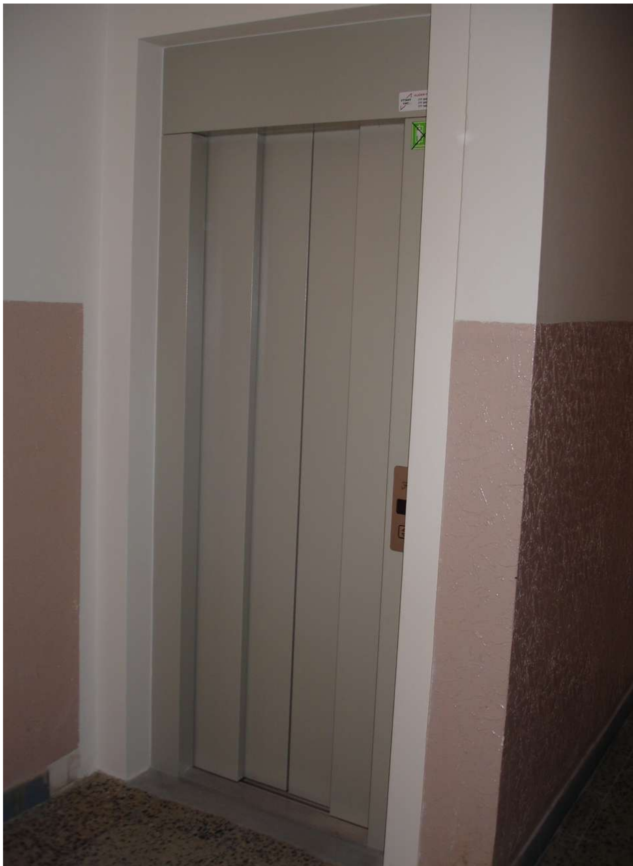
Šachetní dveře automatické- po výměně
