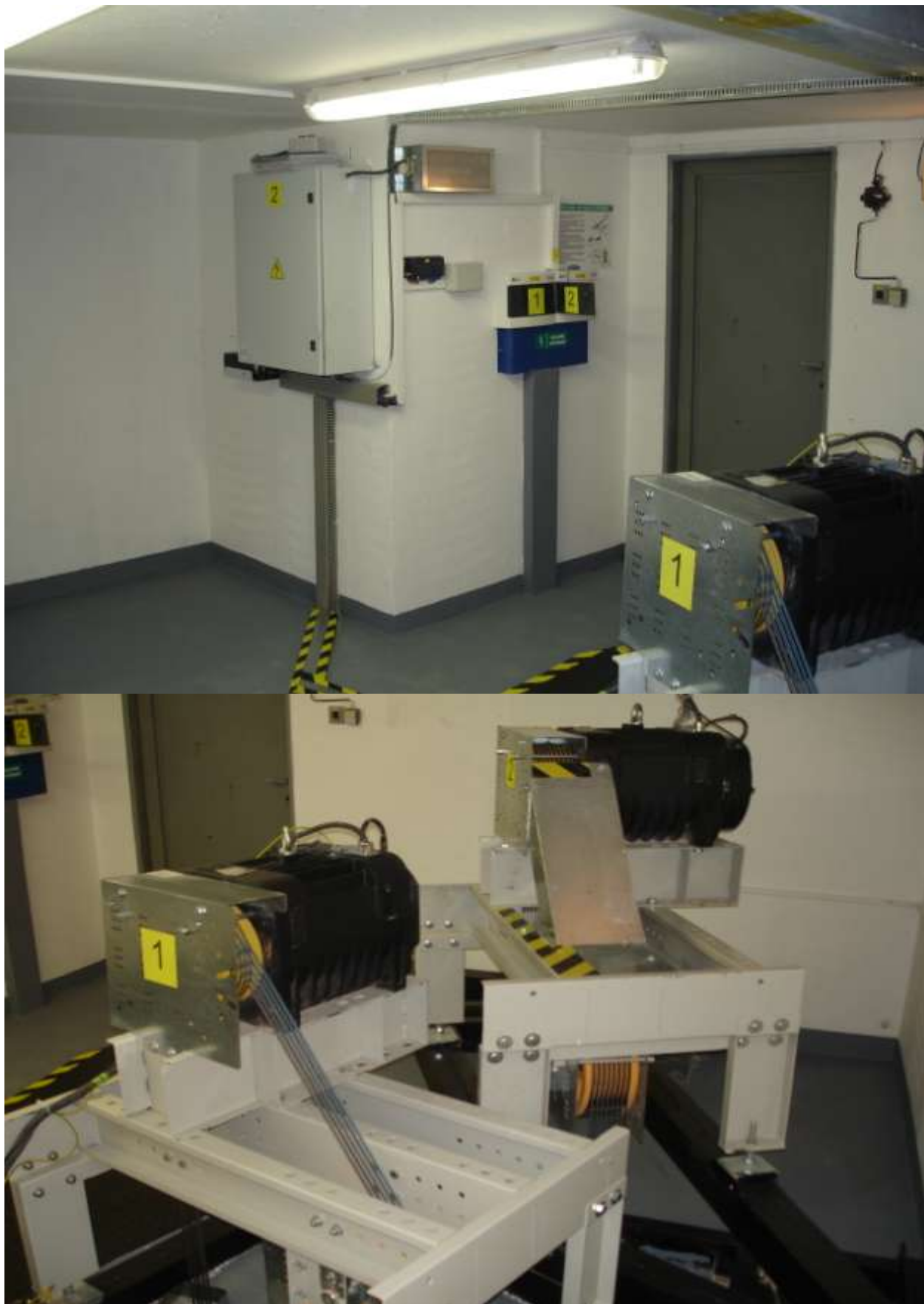
Strojovna již realizovaných výtahů
